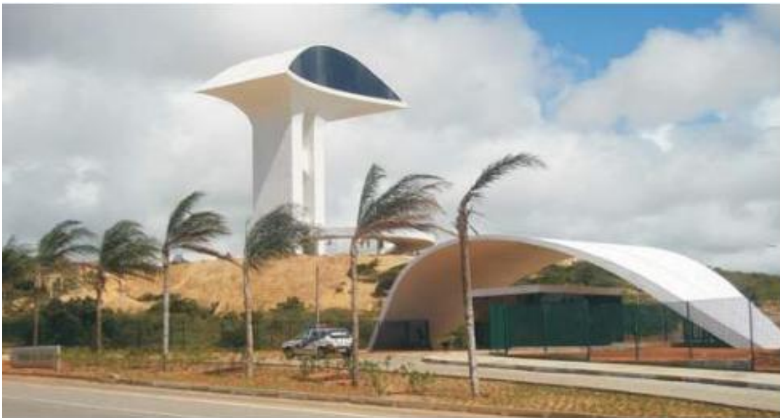
Figure 1 – Pórtico Leste . Source: SEMURB (2008)
