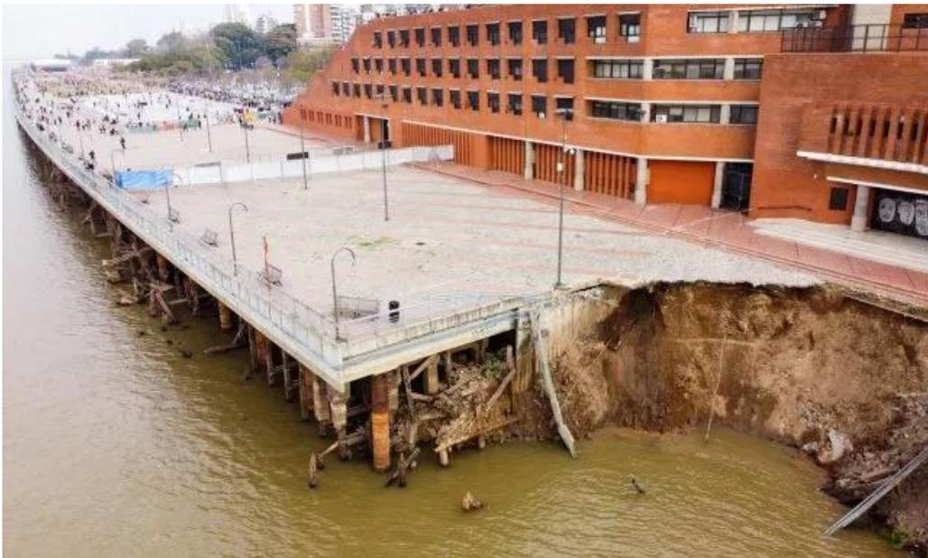
Figura 3: Derrumbe de la barranca bajo el Parque España en Rosario
