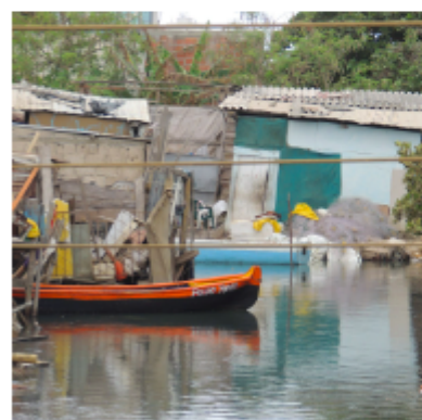
Fotografía 22. Construcciones ilegales a lado y lado del caño Juan Angola, obstruyendo el canal, dificultando la circulación entre la Bahía y la Ciénaga de la Virgen. Fotografía Biontessori 2019
