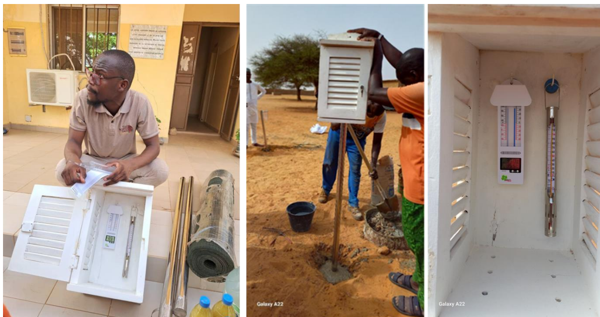
Photos : installation abris et équipements
